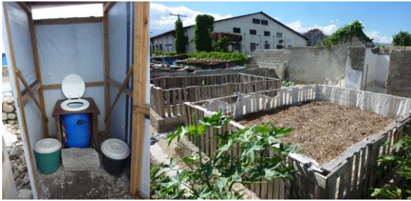
Illustration 1 : Toilettes à séparation Eco San (Haïti)
